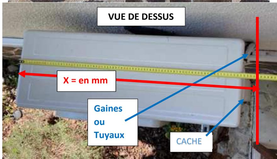
Mesurer à l'extérieur des accessoires : caches poignées et tuyauteries **des 2 côtés** de l'appareil
